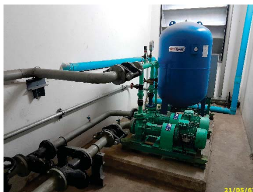
Booster Pump ชั้นดาดฟ้า
